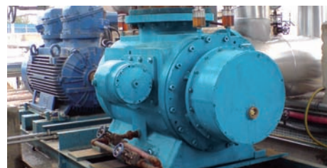
2 Циркуляционный насос L4MG
