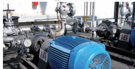
4 Насос L2NG для отходов и дренажного масла
