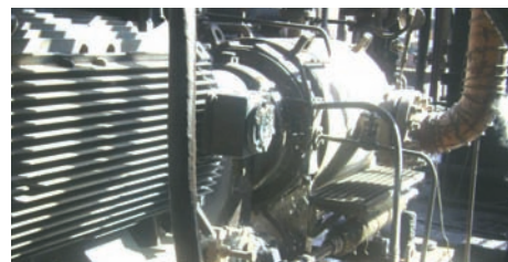
3 Насос L4MG для вакуумного остатка
