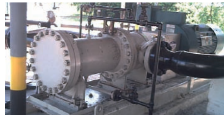
3 Подкачивающий насос L3HG
