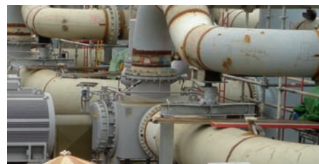
3 Насос L4NG для загрузки и перекачки
