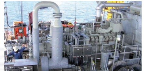
1 Многофазный насос L4НК на морской платформе
