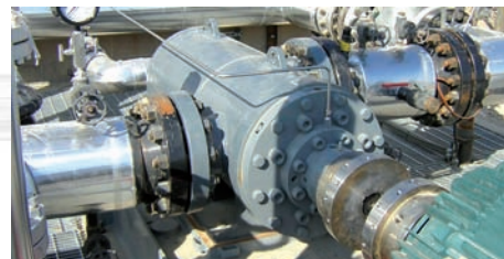
4 Насос L3MG для перекачки
