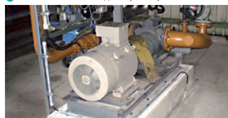
5 Насос L4NG для мойки резервуаров
