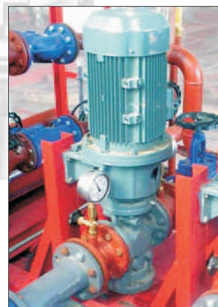
3 4 10 11 FO/DO Насос передачи и сепаратора L3NG
